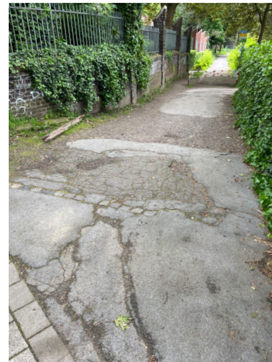
“kaputte Asphaltdecke entlang des Friedhofs” 墓地沿いの道の壊れたアスファルト舗装
