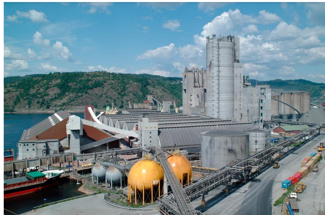
グレンランドにあるYaraのグリーンアンモニアのパイロットプラント
