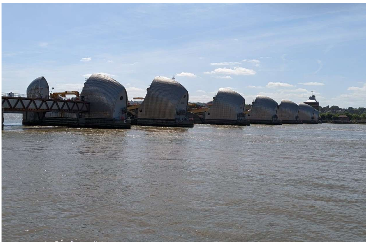
【写真】テムズ川河口域に設置されている、全長 520 メートルにも及ぶ防潮堤「テムズ・バリア」。
