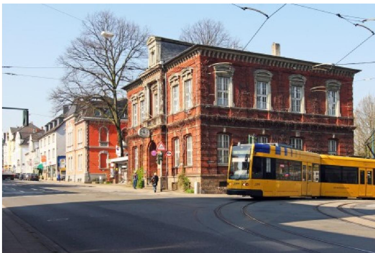
エッセン市の郊外レリングハウゼン地区の路面電車 写真：Carsten Deckert 出所：エッセン市ホームページ
