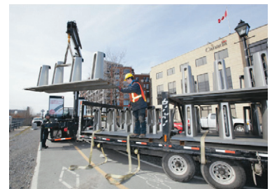
写真2 ステーションの設置工事の様子
