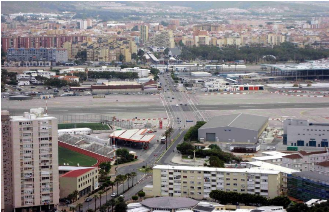
図 13 : ウィンストン・チャーチル通りと交差するジブラルタル空港の滑走路 (Photo by David Stanley/CC BY 2.0 )
